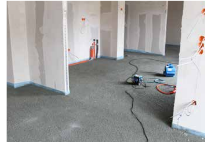
Auf der Holzkonstruktion der Obergeschosse liegt eine 10 cm starke, gebundene Splittschüttung als Gewichtsauflage. Auf sie folgen Fußbodenheizung sowie eine Estrich-Schicht
