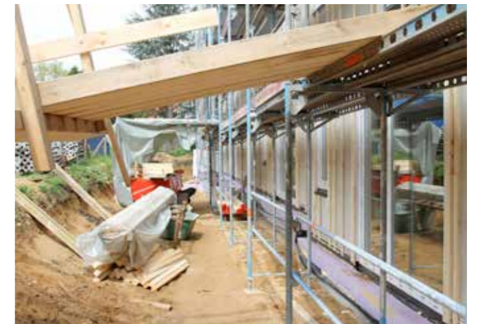
Die erste Reihenhauszeile liegt aufgrund des sanft abfallenden Geländes etwas tiefer als das Mehrfamilienhaus. Nach Abbau des Krans wird das Gelände angeglichen
