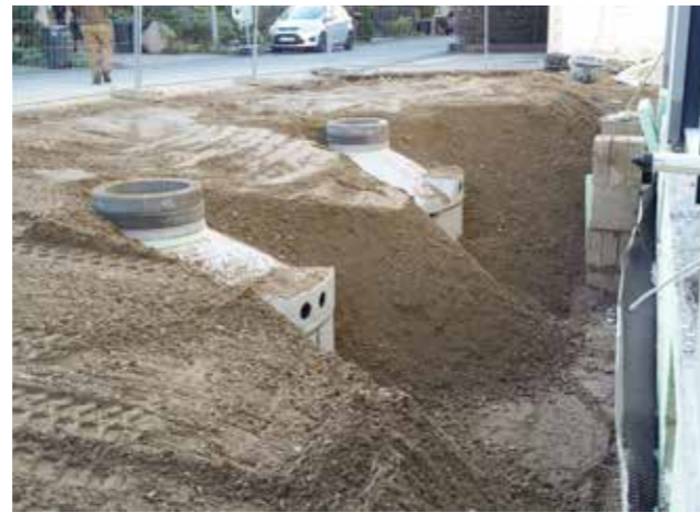
Schnittzeichnung eines Eispeichers und sein Einbau im Erdreich in unmittelbarer Nähe des Gebäudes
