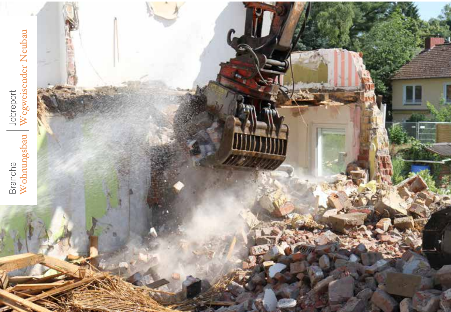
Abriss der ersten Reihe der Bestandsbebauung im Sommer letzten Jahres. Sowohl die ungenügende Dämmung als auch ein nicht mehr zeitgemäßes Platzangebot und eine dürftige Ausstattung sprachen gegen eine Modernisierung
