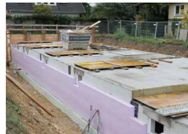
Anfang Dezember 2016: Das Bauverfahren erlaubt eine industrielle Vorfertigung und ermöglicht einen raschen Baufortschritt. Auf das in Ortbeton erstellte Kellergeschoss folgt moderner Holztafelbau mit bereits installierten Fenstereinheiten
