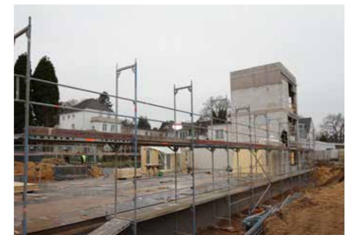
Anfang Dezember 2016: Das Bauverfahren erlaubt eine industrielle Vorfertigung und ermöglicht einen raschen Baufortschritt. Auf das in Ortbeton erstellte Kellergeschoss folgt moderner Holztafelbau mit bereits installierten Fenstereinheiten
